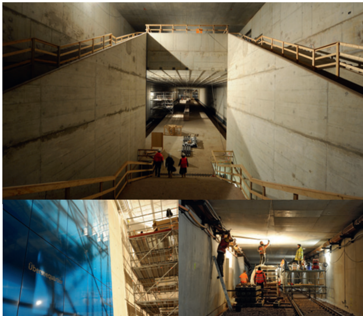
Von der Zwischenebene öffnet sich der Blick in die große Halle der Station HafenCity Universität. Nach der Vollerstellung der Tunnel haben die Handwerker den Ausbau übernommen, in der Station Überseequartier gibt es bereits eine Kostprobe des Innendesigns
