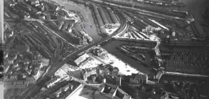
Hannoverscher Bahnhof, Bahntrasse und Quartier Oberhafen, 1931
