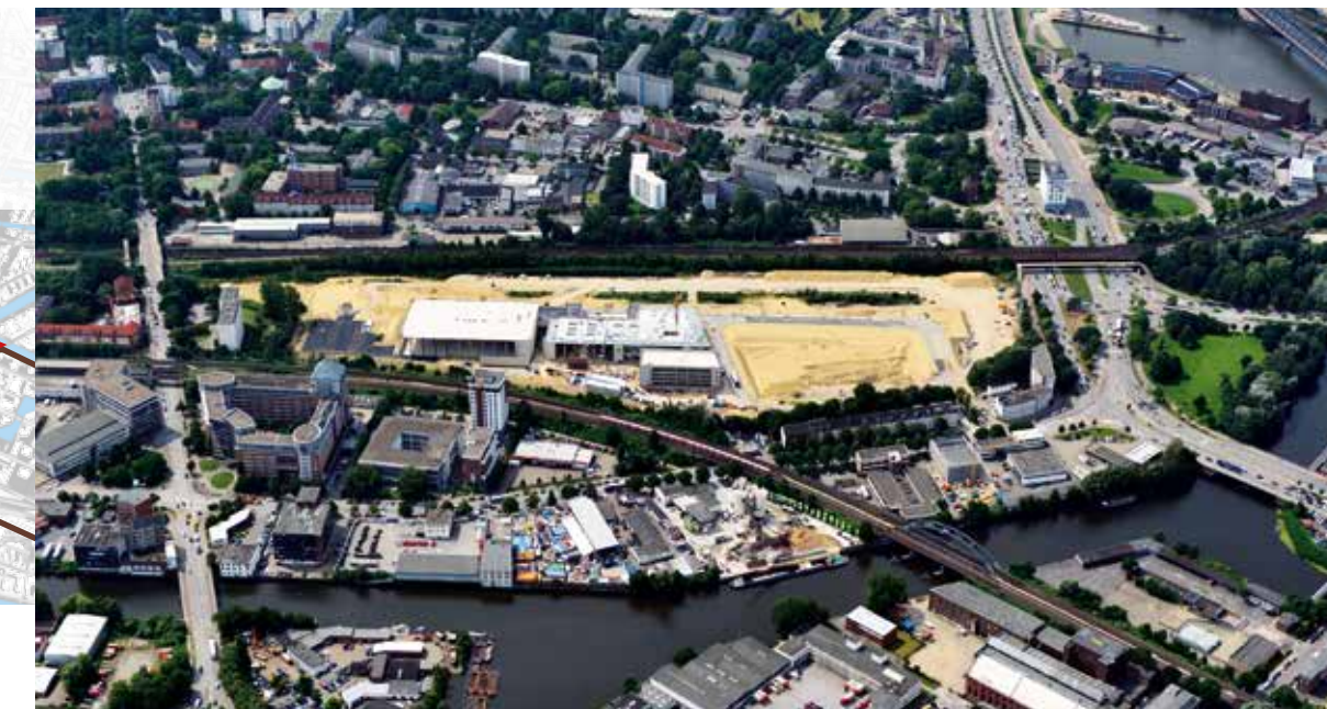
Blick über das Billebecken und den Neuen Hukepackbahnhof mit dem Neubau der Opernwerkstätten
