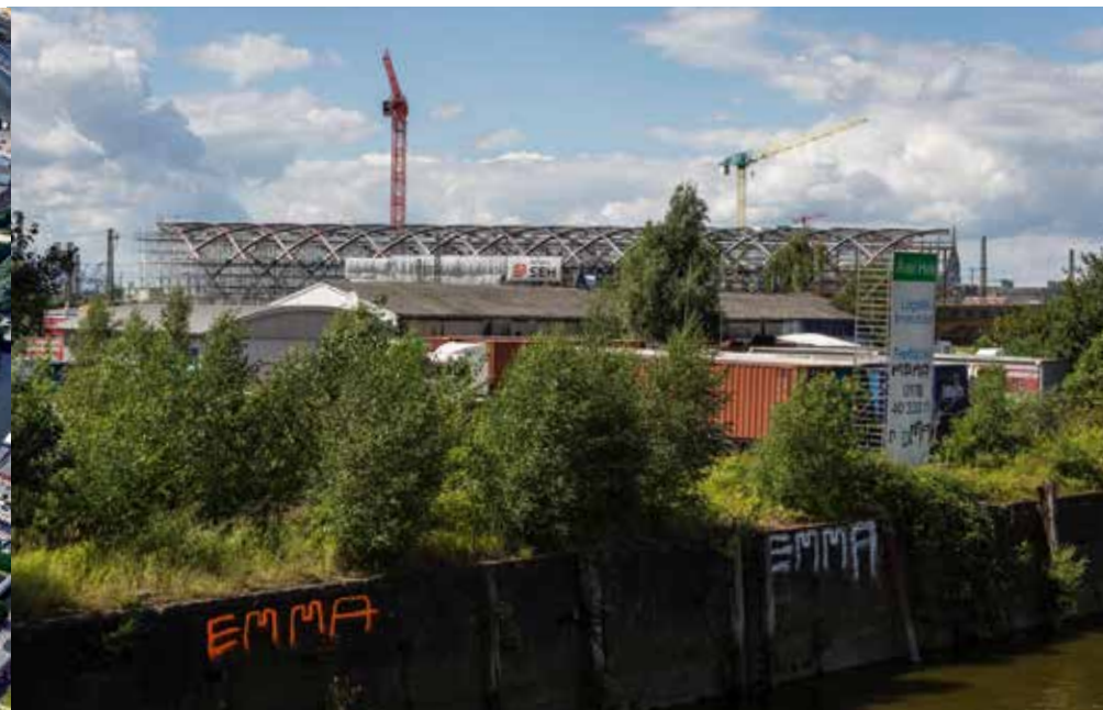
Neuer ÖPNV-Knotenpunkt ab Ende 2018: Die U-Bahnstation Elbbrücken vom Billhafen aus gesehen
