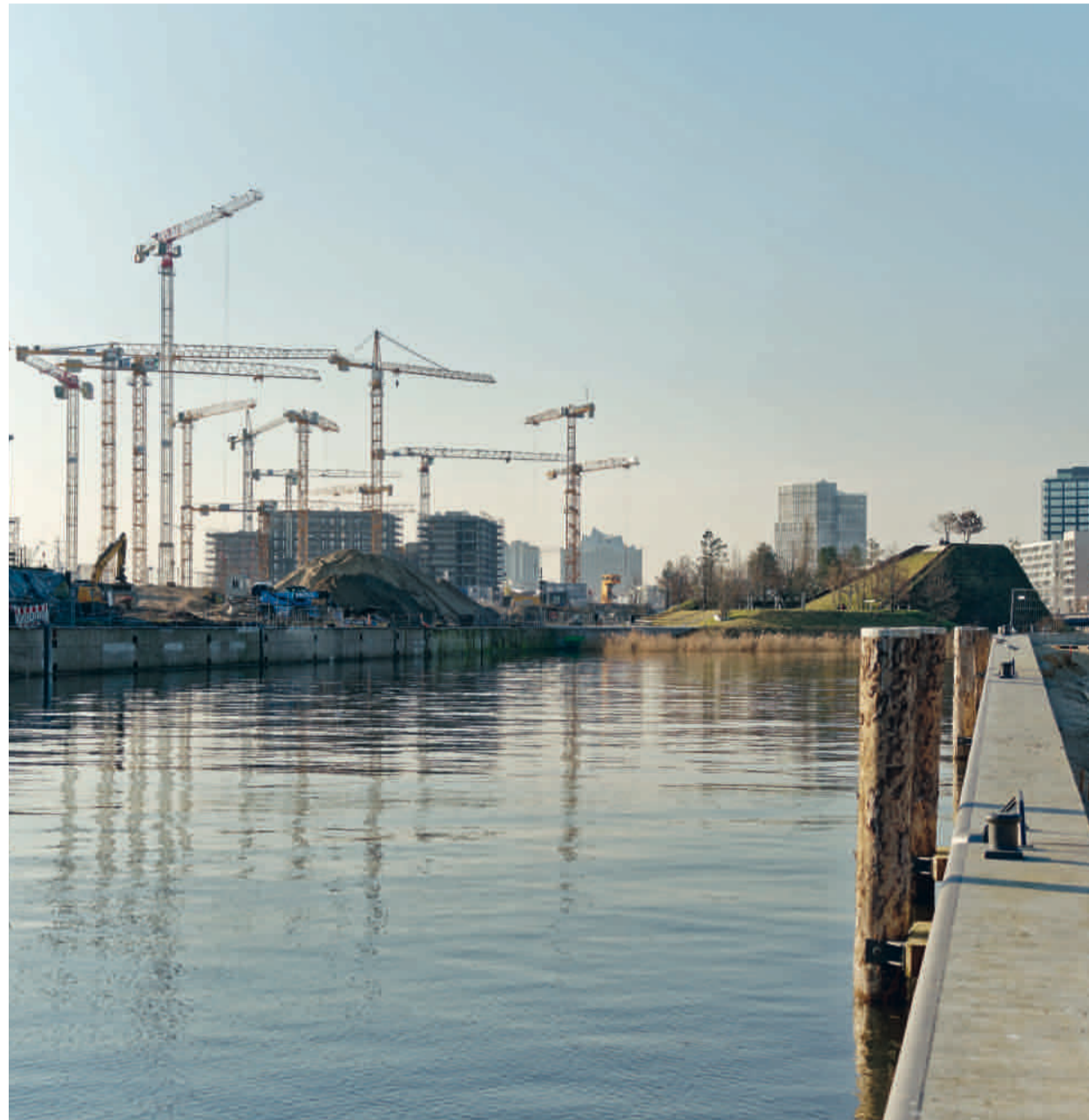
↑ Die imposante Baustelle des neuen Quartierszentrums am Baakenhafen (Foto: Thomas Hampel)
