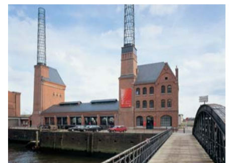
Das Kesselhaus: InfoCenter der HafenCity
