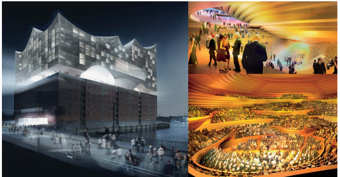
Der gläserne Aufbau auf dem Kaispeicher A bietet innen wie außen eine einmalige Architektur. 2.200 Personen sollen im großen Saal Platz finden
