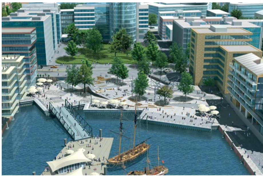
Der Sandtorhafenkopf ist fertig gestellt. Die begehbaren Pontons und Stege werden im Sommer 2006 folgen
