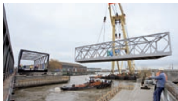
Ein 650-Tonnen-Schwimmkran setzte die Baakenbrücken ein
