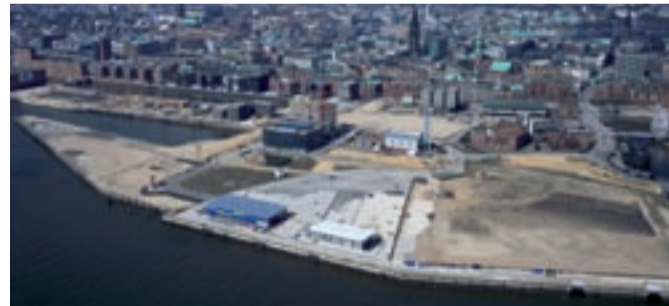
Nach acht Wochen Bauzeit wurde Terminal 2 (rechts) im April eröffnet
