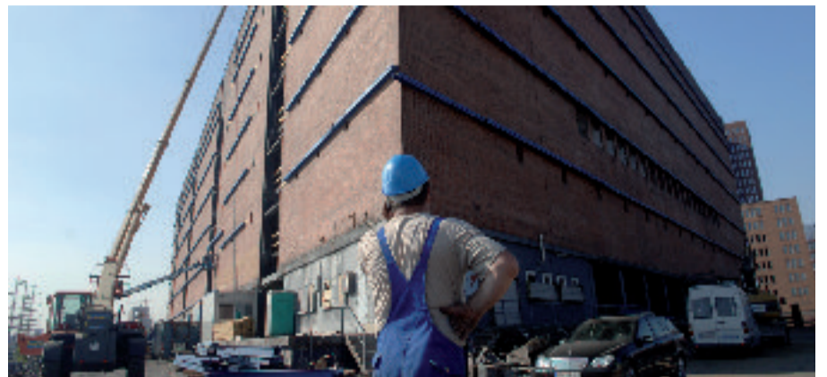
Zunächst wird der Kaispeicher A komplett entkernt, nur die Fassaden bleiben erhalten
