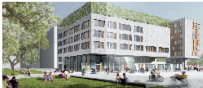
Im Grünen: Das Grundschulgebäude entsteht direkt am Sandtorpark
